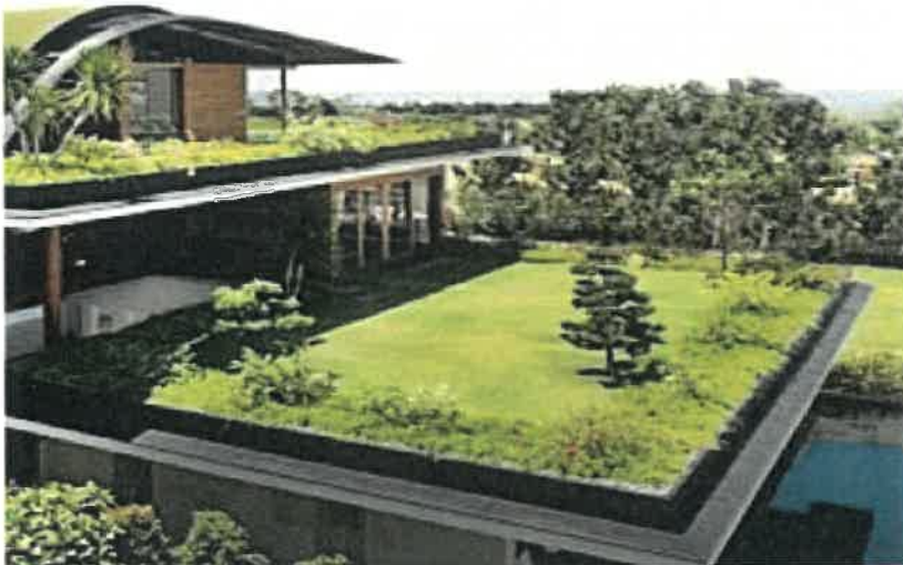
Exemple de toiture-terrasse végétalisée
